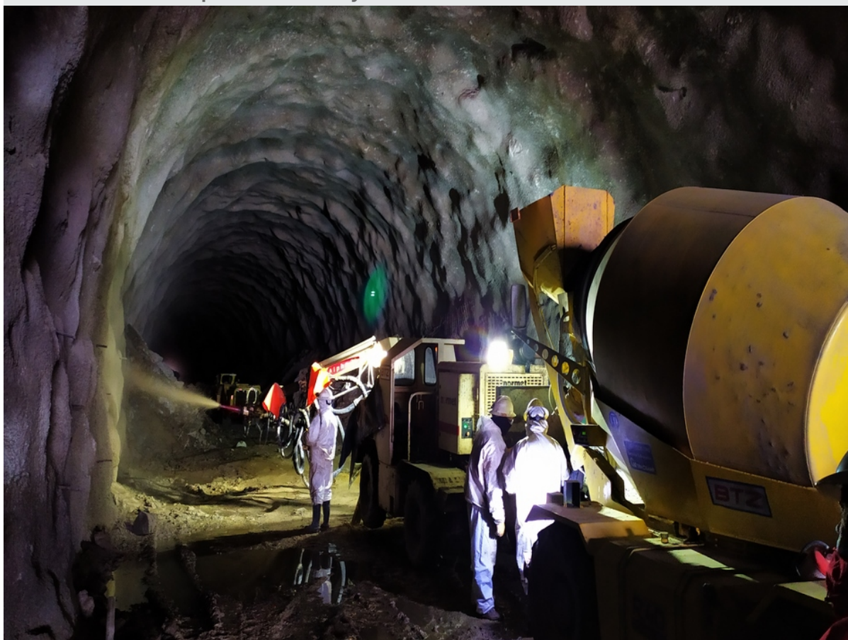
RN 75 - TUNEL Dique Los Sauces y Las Padercitas - LA RIOJA - SUBIDO EL 25-04-2023
